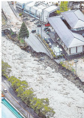
台風7号の影響で陥没した道路。手前は佐治川。16日午前9時51分、鳥取市
