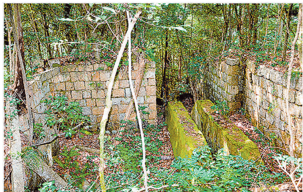
奥ノ院駅のホーム跡。石積みのホームの中央にケーブルを巻き上げる機械の土台が残っている
