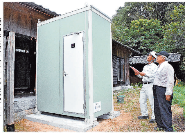
熊野神社に設置されたトイレ。使いやすさに配慮している
