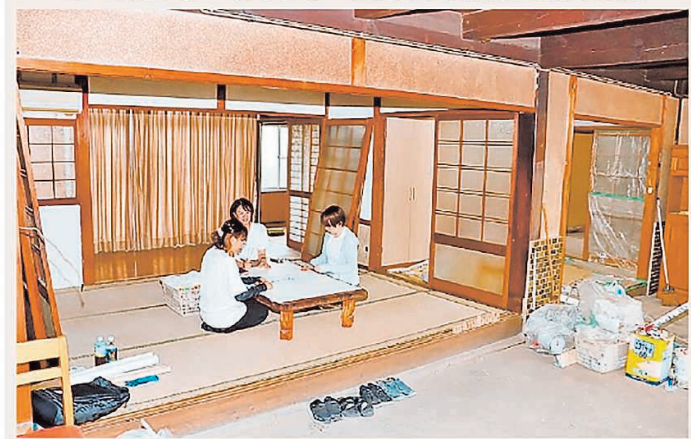
ユースセンター開設に向けて改修中の空き家
